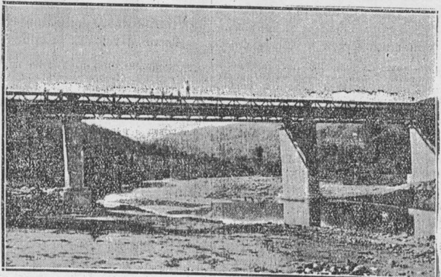
Abbiamo ieri narrato la storia di questo ponte costruito tra Molini di Pareto e Fondoferle. Uno dei massicci piloni che lo sostengono, spostato e inclinato da una piena, è stato rimesso in sesto da Don Piccardo, il raddrizzatore del campanile di Moranego, dopo che numerosi ingegneri avevano sconsigliato l'impresa considerandola quasi impossibile. Il pilone raddrizzato è quello che figura a destra nella fotografia.
